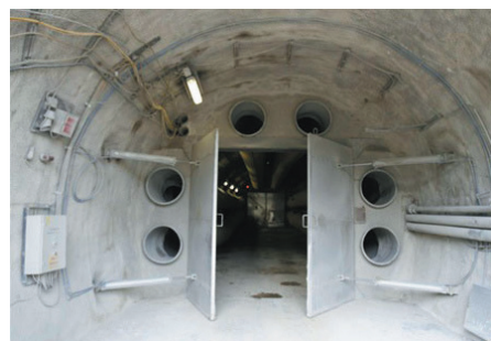
Ústí tunelu během výstavby
