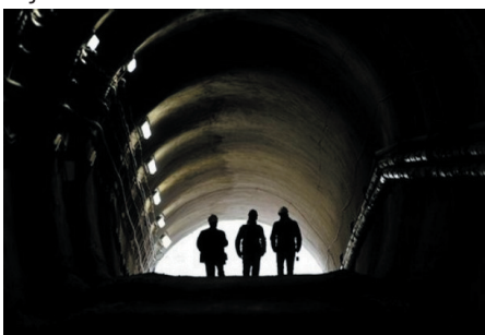
Budování podzemních tunelů
