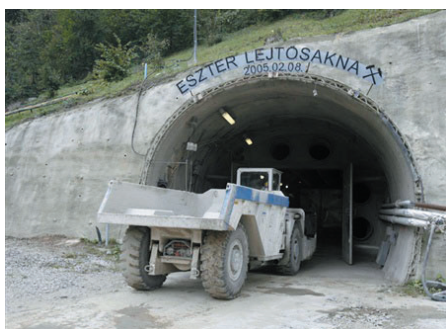
Rozměry tunelů umožňují průjezd těžkých automobilů
