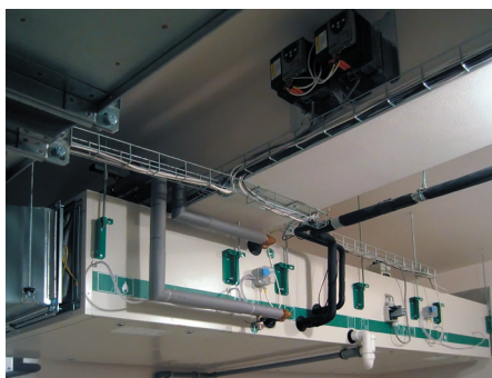
Filtroventilačních a klimatizačních jednotka
