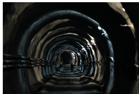
Uvnitř jednoho z budovaných tunelů Škoda, že z pochopitelných důvodů zde nemůžeme blíže popisovat jednotlivá zařízení a provozní procedury, ale i tak doufáme, že pro řadu aplikačních inženýrů bude toto nasazení zajímavé a inspirující.
