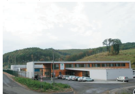
Vstupní objekt areálu úložiště
